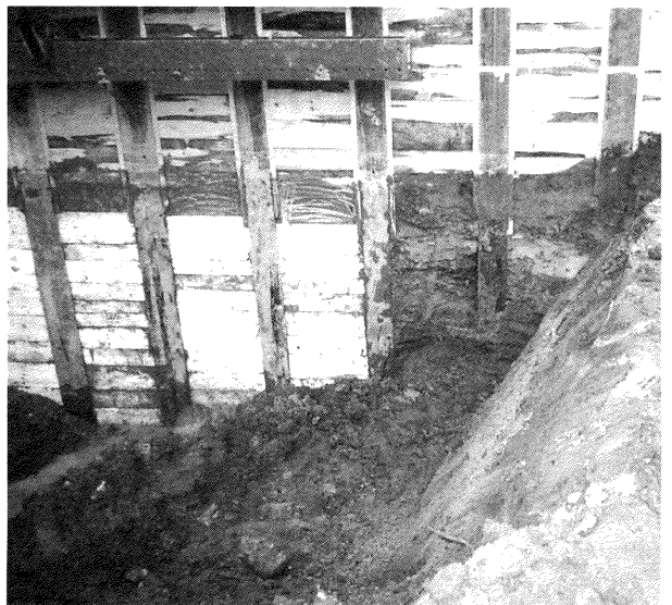
N3 付近 オシ沼砂礫層まで掘削されると，直ちに矢板でおおわれ，長さ不可能となった。
