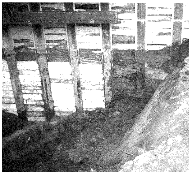
N3 付近 オシ沼砂礫層まで掘削されると，直ちに矢板でおおわれ，長さ不可能となった。
